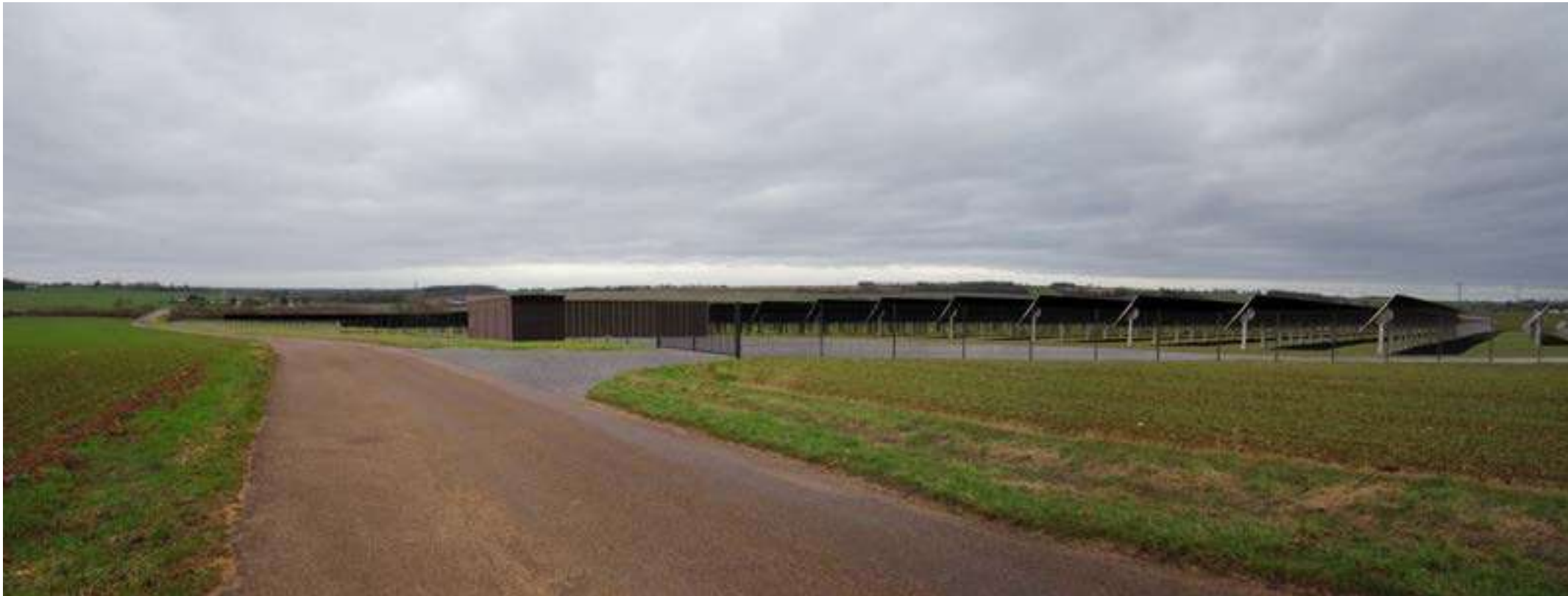
Point de vue 4 : Depuis la D110, à proximité immédiate du secteur Sud Vue 4 - état avec projet, sans mesures paysagères
